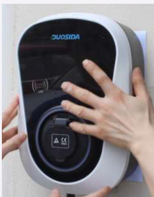
7. Accrochez le corps principal de la station de charge sur la plaque de montage
